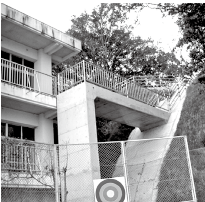
伊田小学校高台への避難橋
