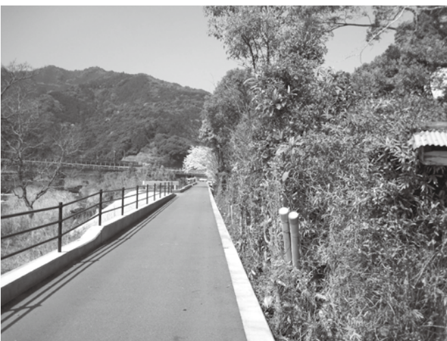
支障になる樹木を伐採した道
