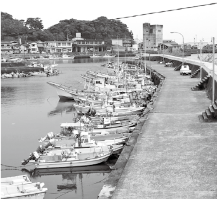
佐賀漁港防波堤かさ上げ工事 (H25年3月末現在)
